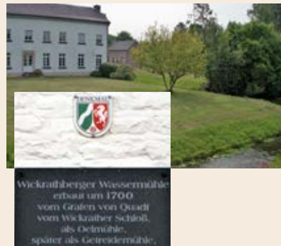
Wassermühle an der Niers in Wickrathberg - sie diente zeitweise ebenso wie die Genhofer Mühle als „Bannmühle“ des Reichsfreiherrn.
