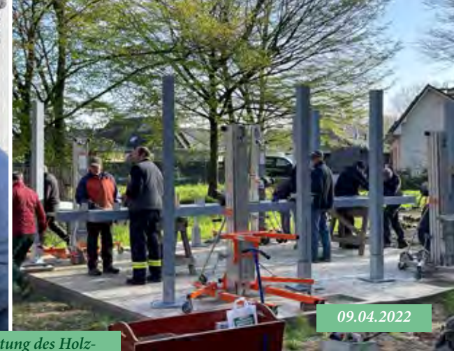
Die Errichtung des Holzständerwerkes war das Highlight der ersten Phase
