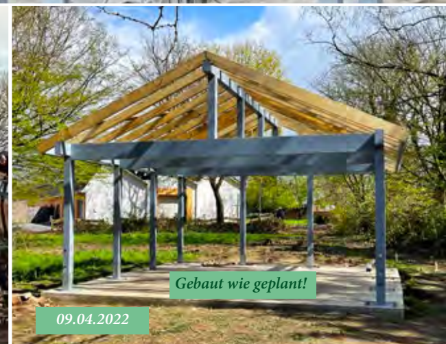
Der Dachstuhl folgte noch am selben Tag
